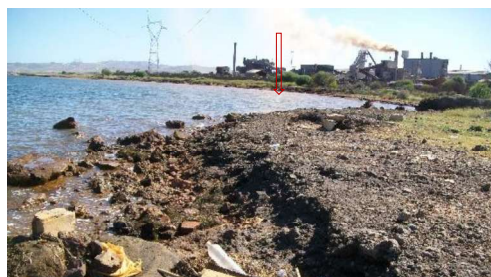
Eau rouges et début de formation de couche crème par les rejets d'El Fouledh. Cliché S. Tlig
