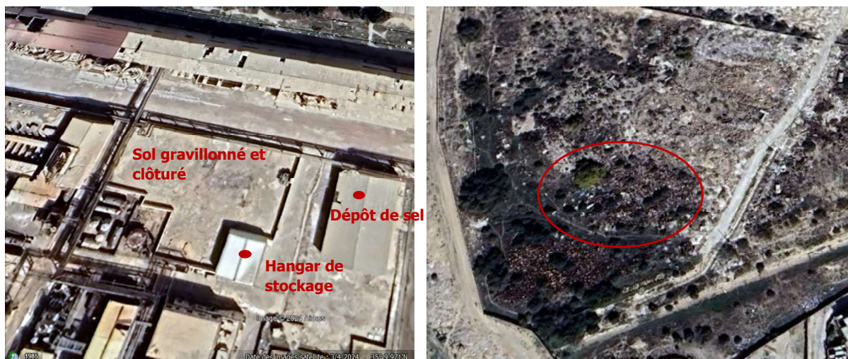
Figure 21. Etat actuel du site mis en sécurité de l'unité d'électrolyse à mercure, montrant le terrain dégagé et clôturé, le dépôt de sel avec du mercure gardé en potiche, le hangar emplit de déchets contaminés en attente de traitement et d'élimination et plus au Sud-Ouest, le dépôt de ferrailles à découvert.
