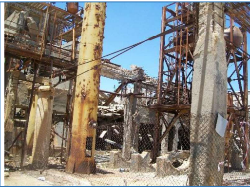
Photo 8 : Tours d'acide sulfurique pour la dessiccation du chlore de synthèse.
