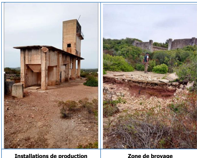
Figure 13. Photo illustrant le bâtiment de l'usine de production de mercure vierge et du site des installations de broyage. Le matériau broyé est livré à l'unité de production par bande transporteuse.
